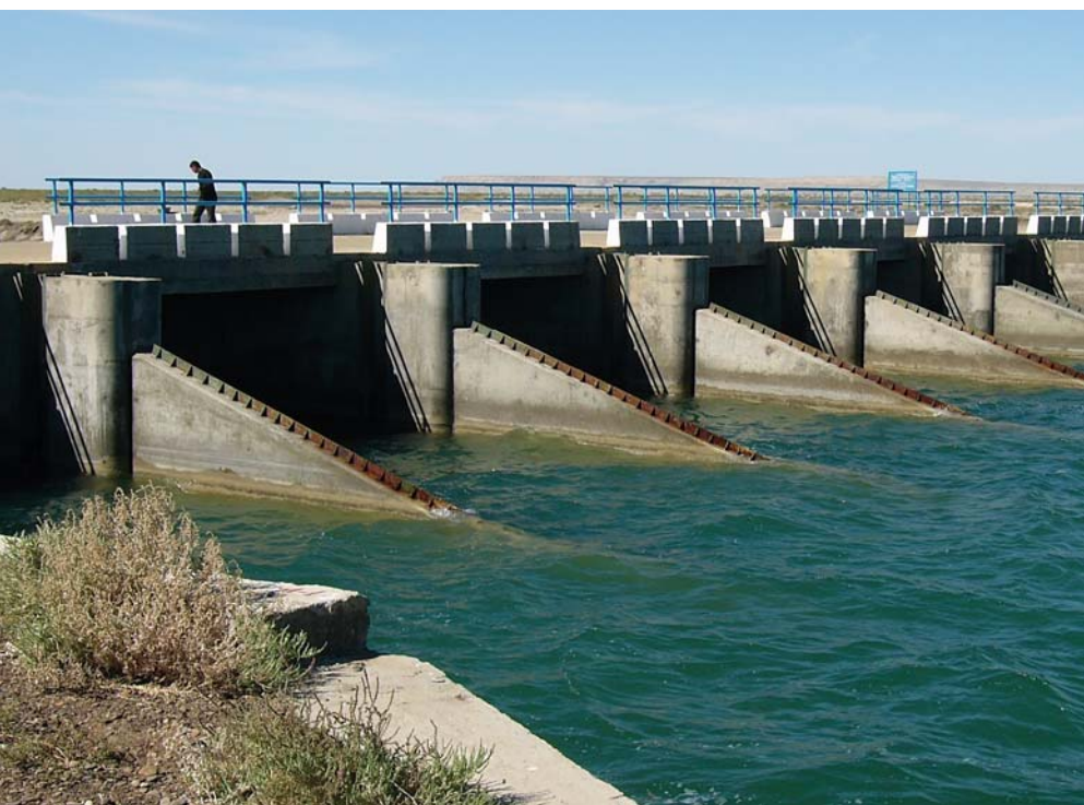
13-КИЛОМЕТРОВАЯ ДАМБА И ПЛОТИНА С ГИДРОТЕХНИЧЕСКИМ ЗАТВОРОМ (вверху), построенные Казахстаном в 2005 г., спасли Малый Арал, прекратив отток воды по пересыхающим, ведущим в никуда каналам. С тех пор наблюдается повышение уровня воды и рост рыбных популяций (внизу). Гидротехнический затвор, законченный в ноябре того же года, позволяет пропускать лишнюю воду для регулирования уровня водоема. Уже к следующему лету вода в Малом Арале поднялась на 2 м
